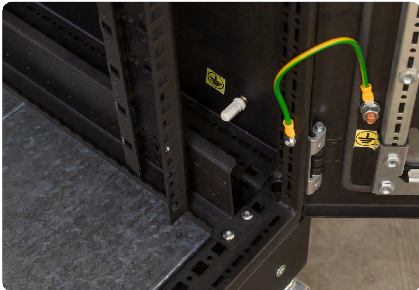
Пример заземления проводящих частей.
