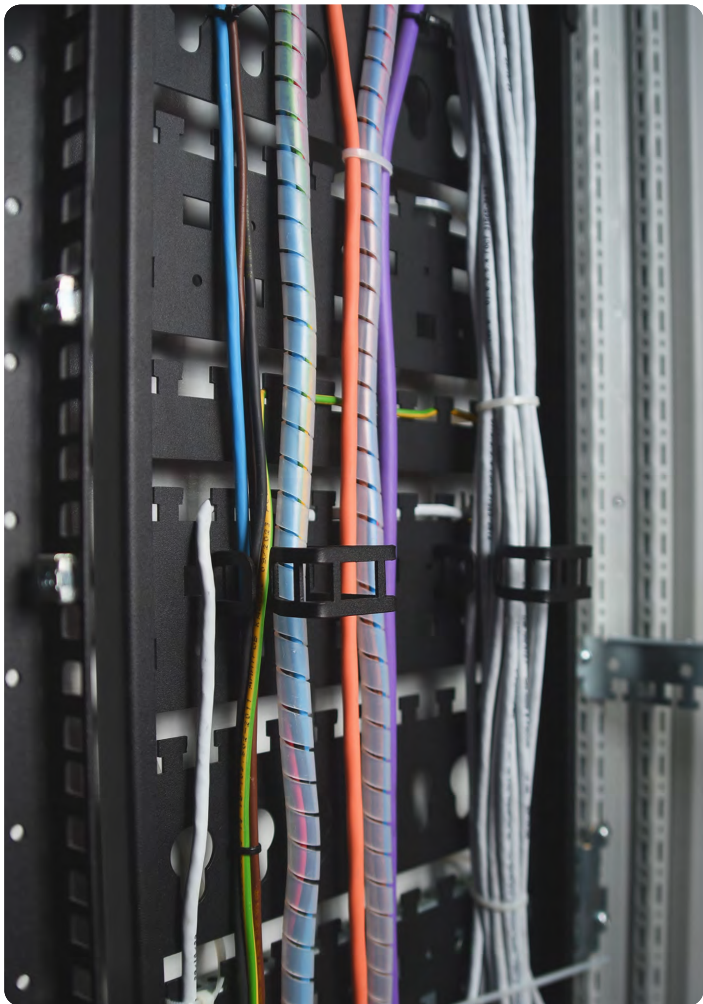
Пример укладки проводов в кабельную трассу.
